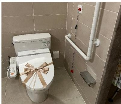
4.9.13 有无障碍需求的卫生间面积应满足轮椅通行要求，轮椅需要通行的区域通行净宽不应小于 0.9m，通行条件不足时，可利用家具、洁具下部的空间帮助轮椅回转。
