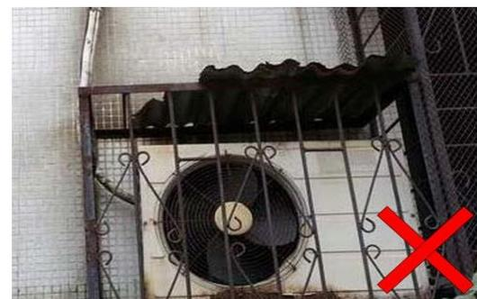
遮盖率过低，铁栏杆锈蚀致墙面污染。
